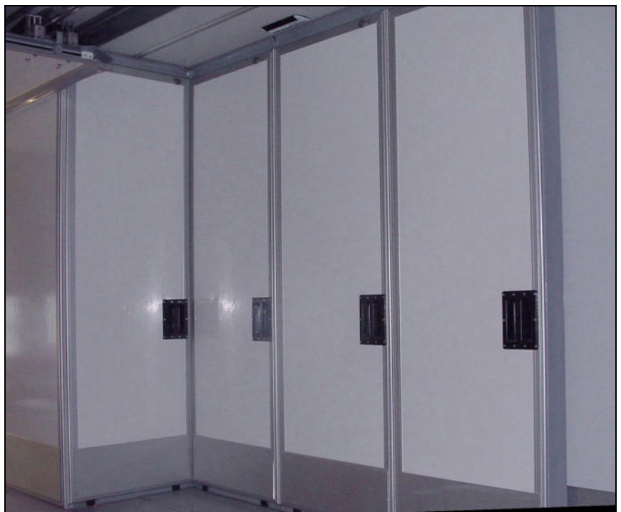
Verkleinerung, oder Vergrößerung des Raumes, in weniger als 1 Minute. Verriegelung durch Magneten.
