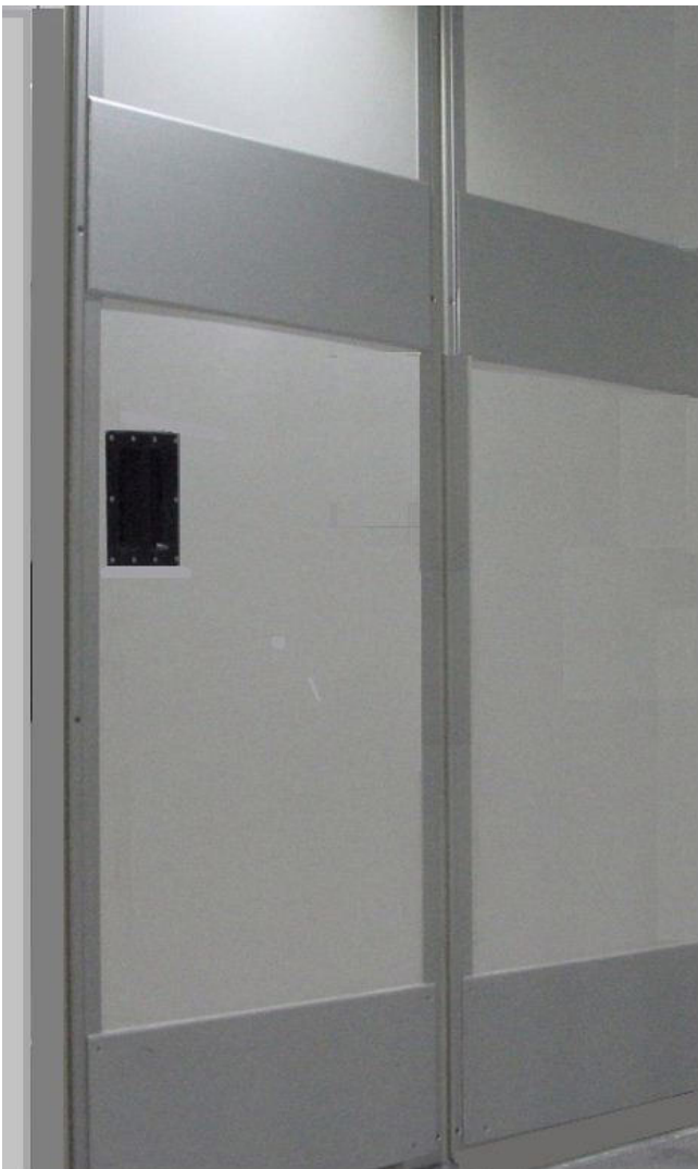
Oben, 1400 mm Unterkante Rammschutzleiste, für Rollhöhe 1530 mm
